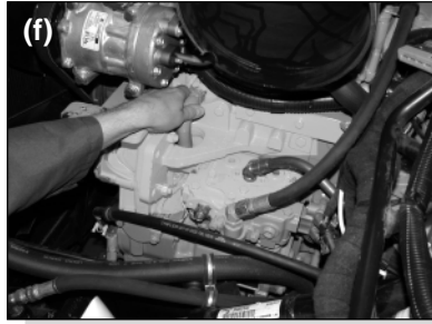
Inspeccionando las mangueras del refrigerante.
