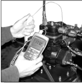
Probando la temperatura en la conexión de la descarga.
